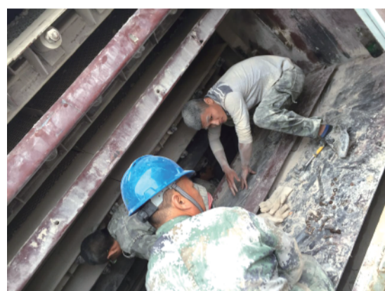
▲设备租赁公司员工设备维护现场
