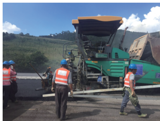
▲设备租赁公司员工路面施工作业现场
